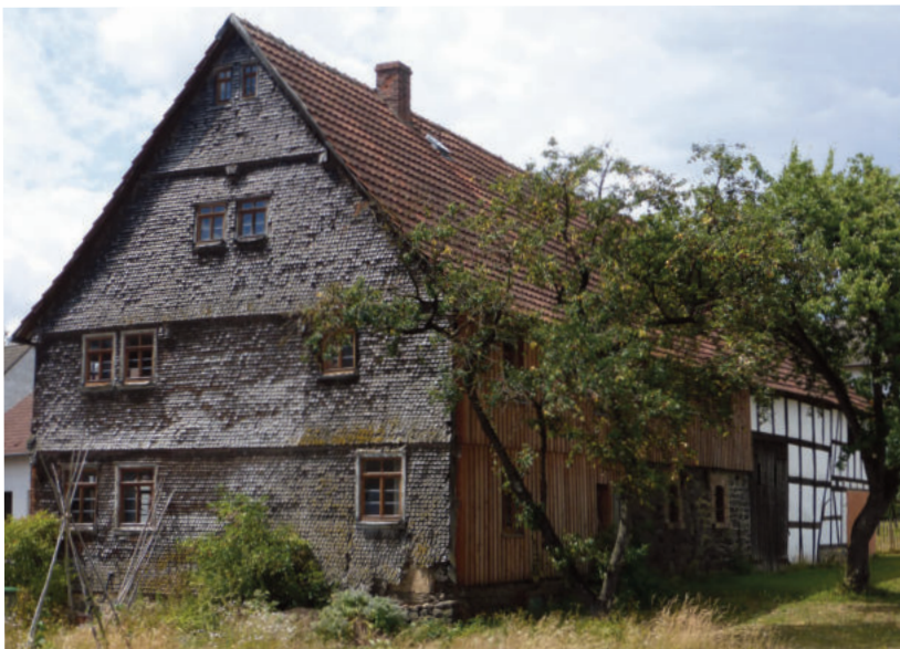
Am "Frankes Haus" wird fleißig renoviert und gebaut
